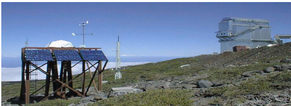
Fig.3 - La torre di supporto del DIMM con gli ausiliari installati (meteo, modem, solar panel). Sullo sfondo la torre meteo del TNG, e sulla destra il building del TNG.
