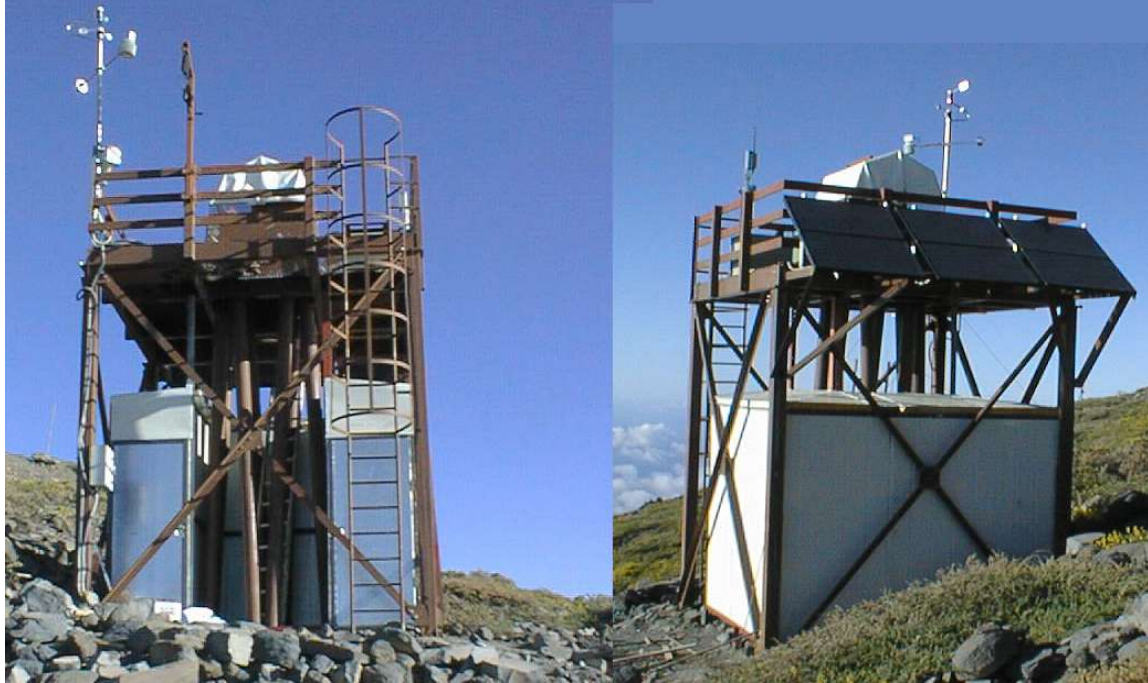
Fig.1 – Vista della torre completa del seeing monitor e di tutte le attrezzature
