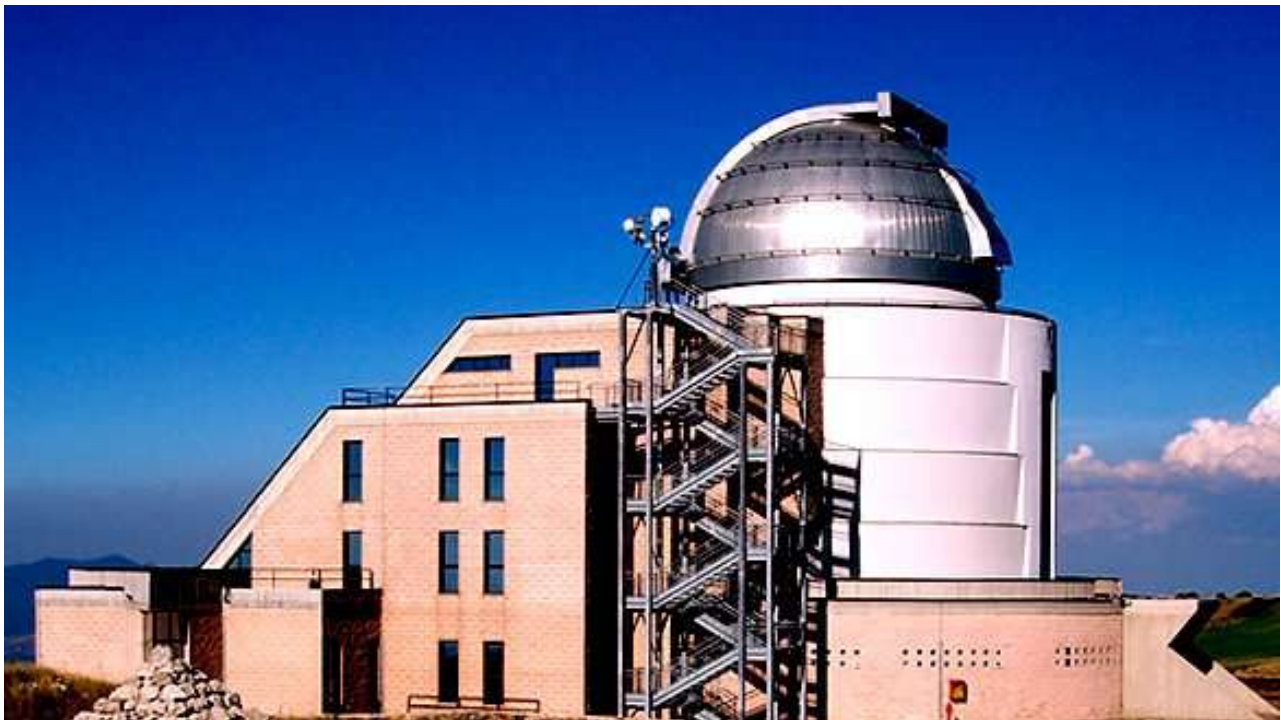
Fig.1 – La stazione astronomica di Castelgrande. LA sezione a sud è coibentata e la stazione è provvista di compensazione termica passiva ed attiva.
