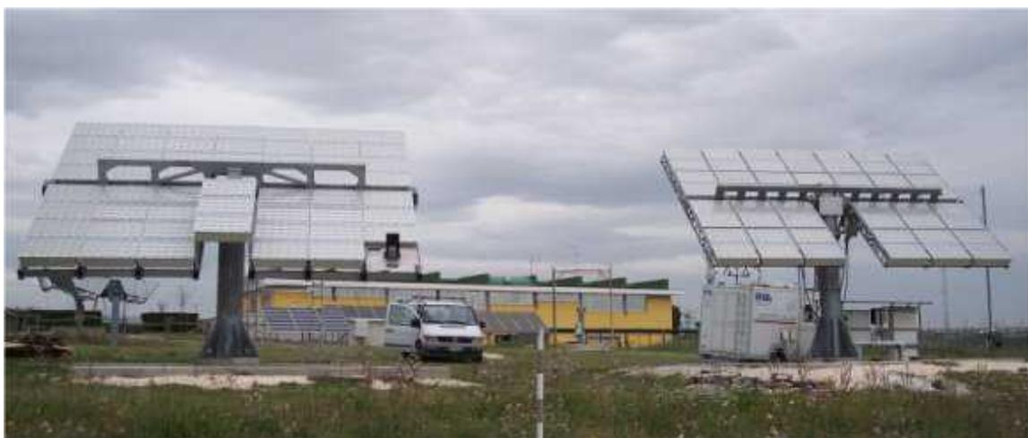
**Due trackers di circa 40mq ciascuno realizzati secondo due metodologie di approccio. Quella di destra di tipo prototipale e di verifica delleprestazioni dei moduli a concentrazione. Quella di sinistra industrializzata rispecchia le caratteristiche della precedente ad un costo di produzione nettamente inferiore.**
